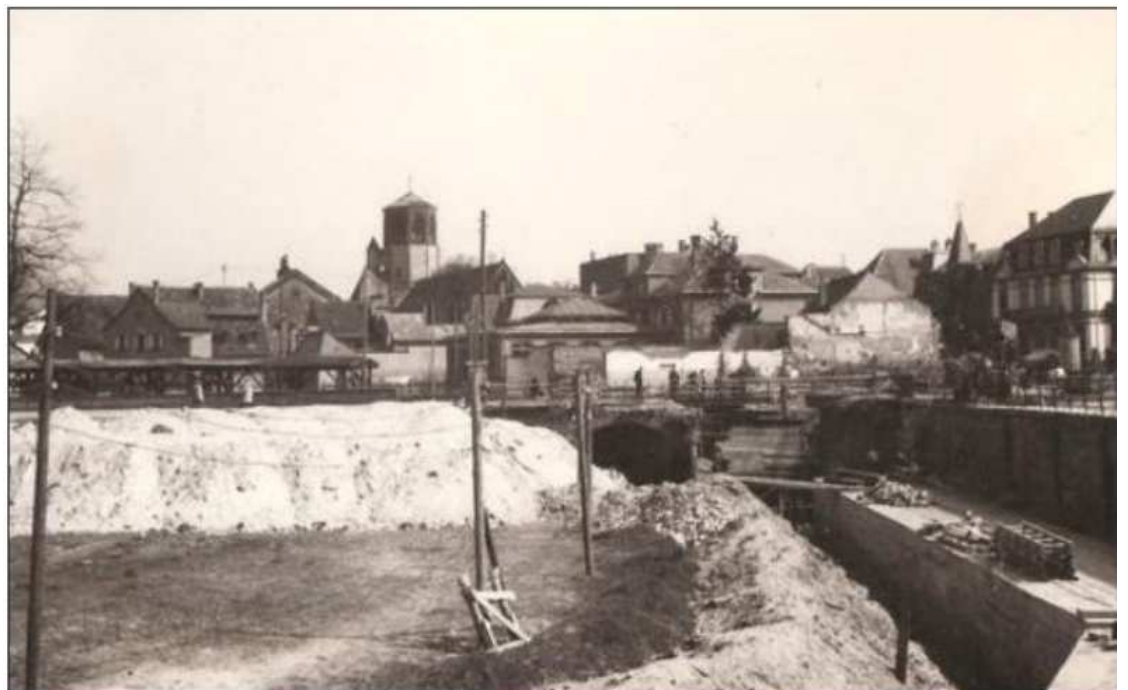
Les travaux de recouvrement de la Moder, approuvé en 1948, ont duré dix ans. Document remis
