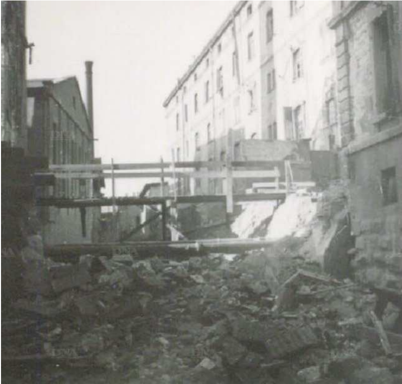
Pendant la Seconde Guerre mondiale, les ponts enjambant la Moder à Haguenau ont été détruits. Document remis
