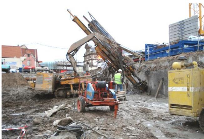
Les ancrages à gauche de la photo ont plongé dans l'ancien lit de la Moder, instable par nature.
